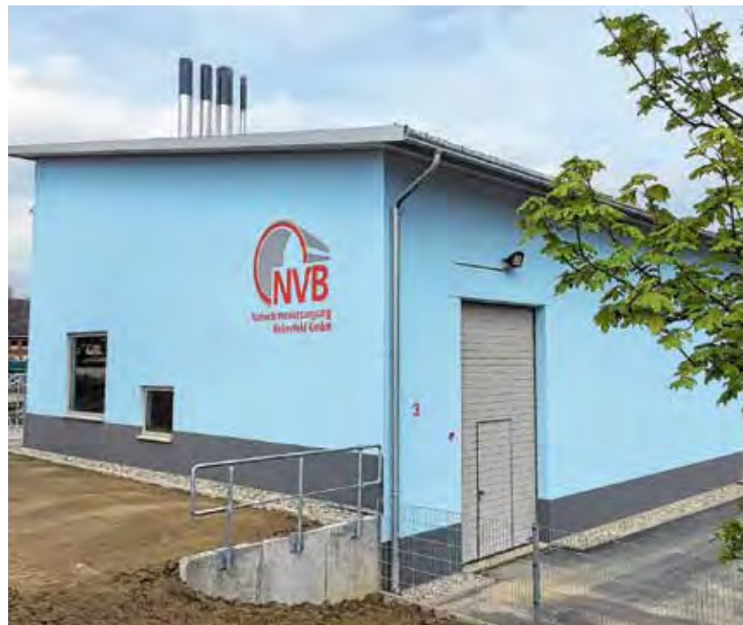
Heizzentrale Nahwärmeversorgung Birkenfeld
